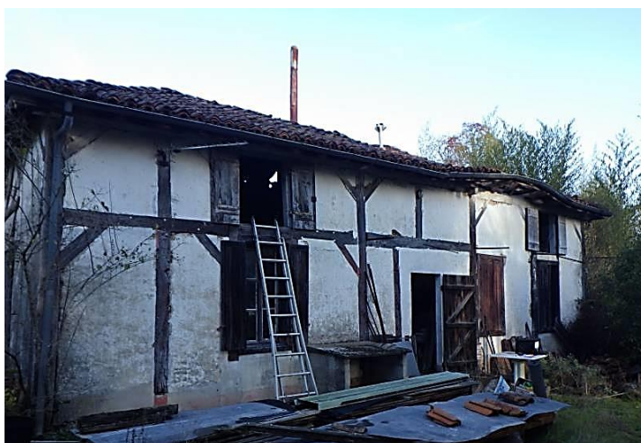
Figure 13 Maison landaise en réhabilitation (Source: GM Expertise)
