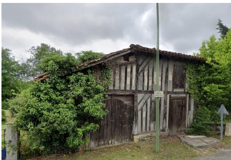
Figure 14 Maison 1 route de Bouheben
