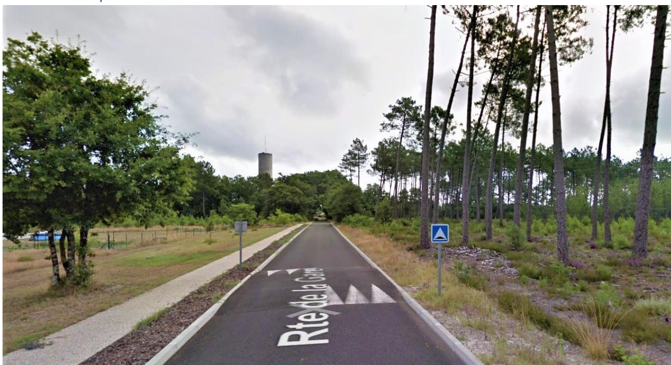
Figure 73 Ancienne piste forestière transformée en voie secondaire en enrobé pour desservir le lotissement Capcos.
