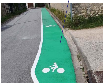
Figure 57 Exemple de marquage voyant (cyclable ou piéton) pour le pont Capcos-château d'eau
