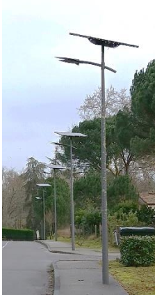
Figure 9 Candélabres photovoltaïques
