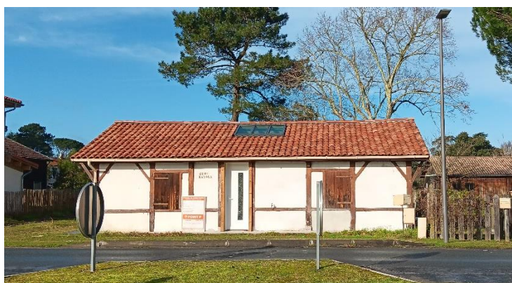
Figure 90 Maison à pans de bois réhabilitée
