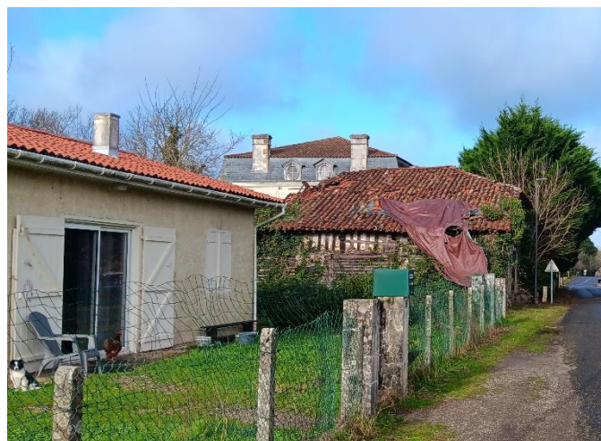
Figure 76 Bâti délabré route de Bouheben racheté par la commune
